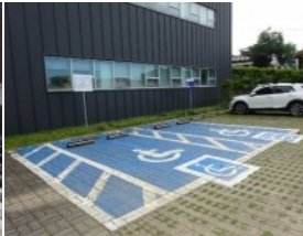
통행로가 확보되지 않는 주차장
