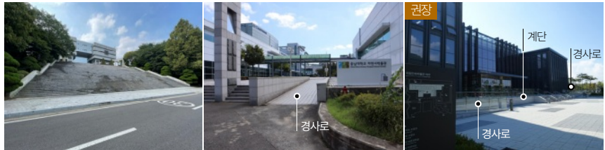
지양: 계단만 설치한 출입구 지양: 경사로가 있으나 안전바 미설치 권장: 양방향의 경사로와 계단 설치
