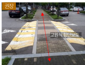
단절된 보도를 연결하는 고원식 횡단보도 설치
