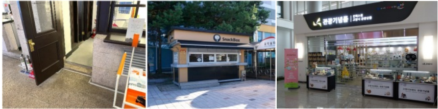
휠체어 이용자 및 시각장애인 등 일부 이용자의 접근과 이용이 어려운 카운터 및 출입구
