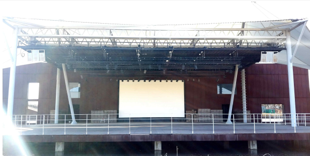
공연장 내 스크린
