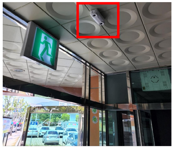
<무인계수기 설치 후>
