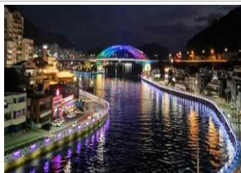
통영 강구안 수변 경관조명
