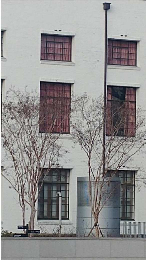
덧창 설치(외부 근경)
