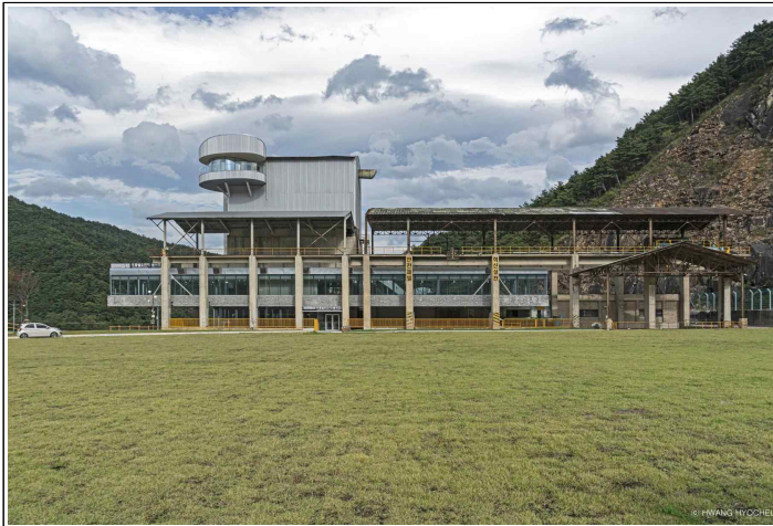
동해 왜석장 리모델링(문화및집회시설, 동해)
